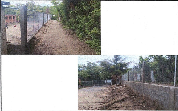
Foto 1: Vista lado Este, finalización de mejoramiento de cerramiento perimetral del centro educativo.
