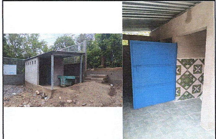
Foto 4: Vista finalización de mejoramiento y reparación de servicios sanitarios y sus accesorios del centro educativo.
